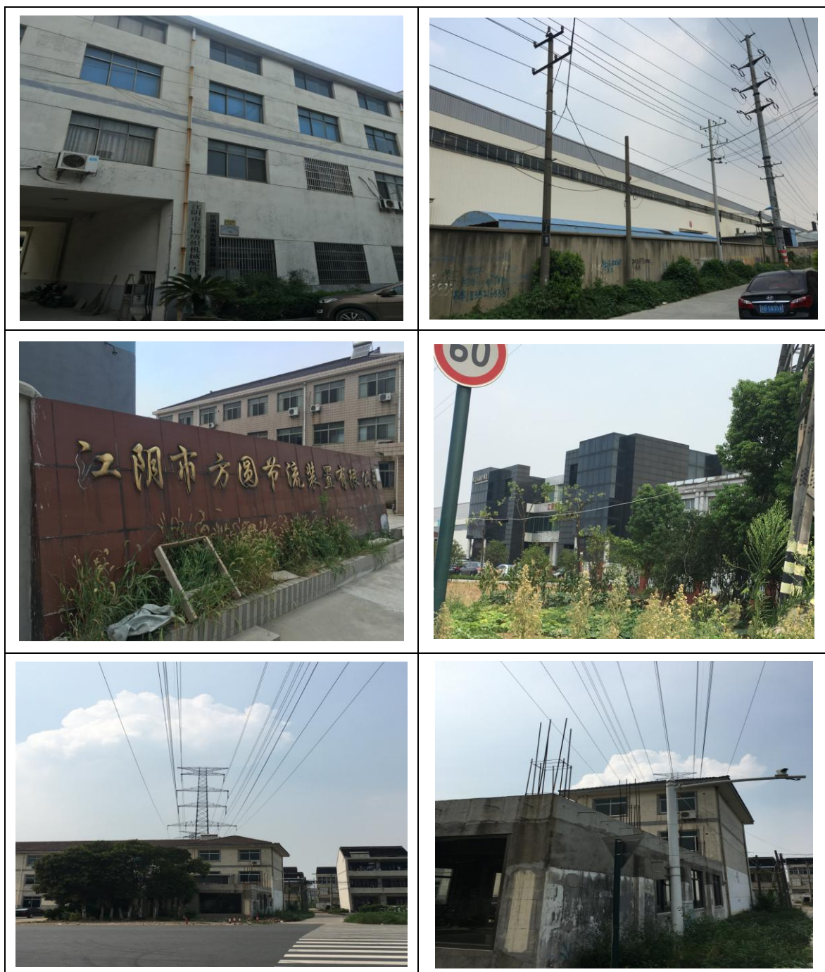
图 1.7-1 110kV 东城线沿线敏感目标现状照片
