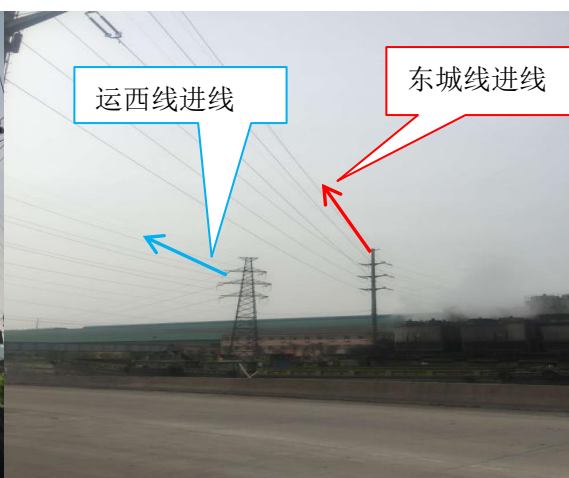
图 1-9 西城变电站进线
